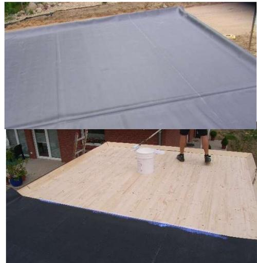
Die zurückgeschlagene Dachbahn auf den mit Kleber eingestrichenen Teil ziehen und mit einem Besen andrücken, sodass möglichst alle Blasen beseitigt werden.
